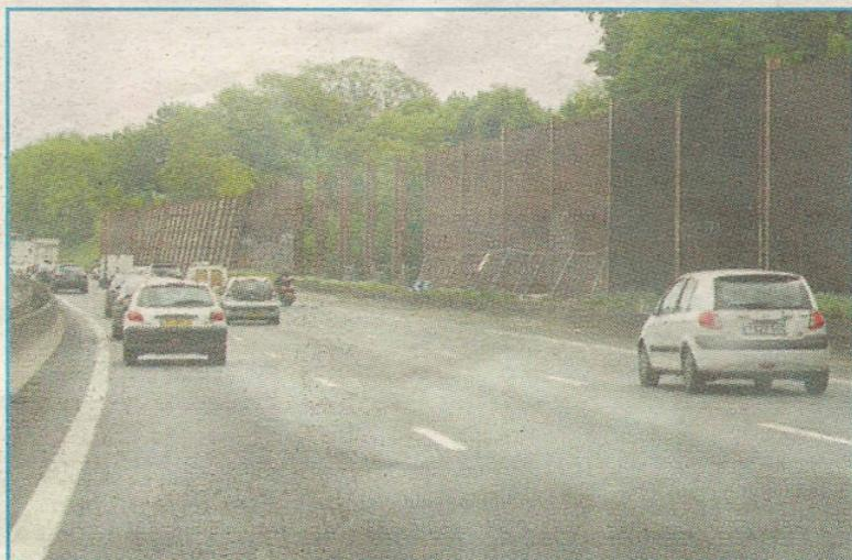
**Conjugué avec la réalisation annoncée par la Drif (Direction interdépartementale des routes d'Ile-de-France) d'enrobés acoustiques sur ce tronçon de la RN 104, l'écran anti-bruit permettrait d'obtenir un gain d'au moins 3 décibels.**
